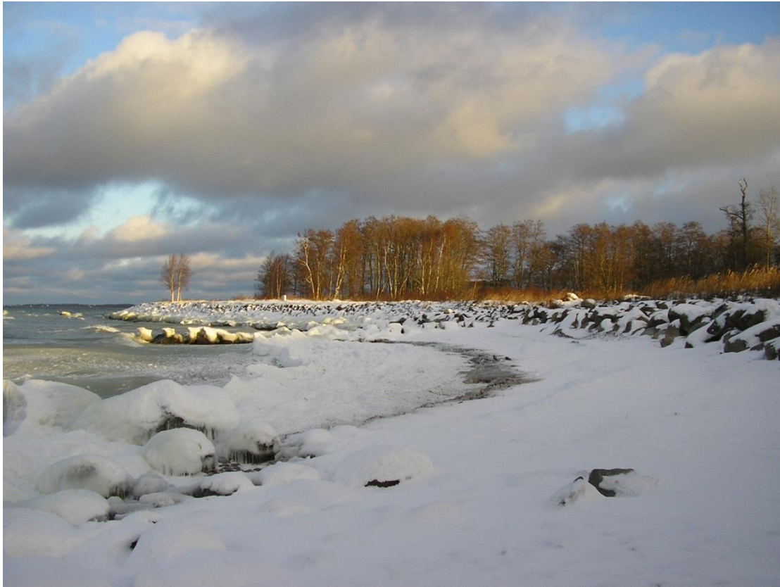
Foto 2. Ala põhjaosas rajatud õiguslikul alusel rannakindlustus
